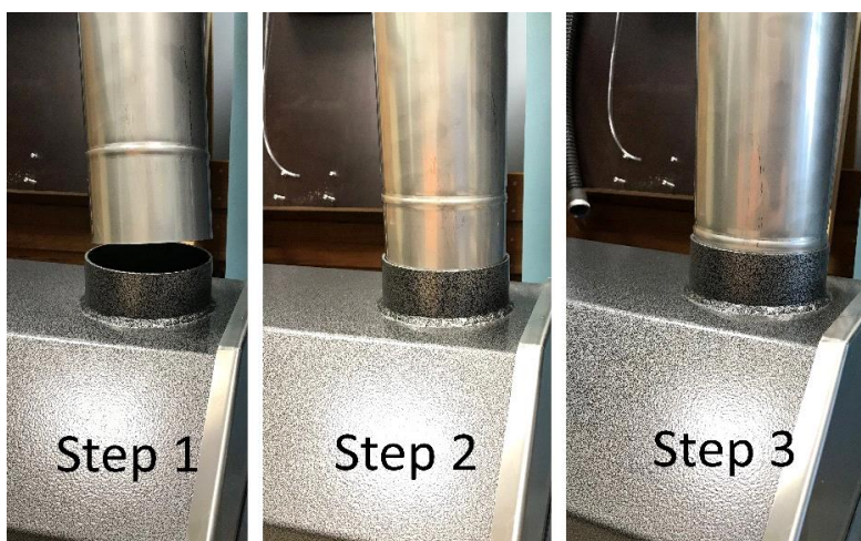
Kuva 7. Savupiipun asennus
