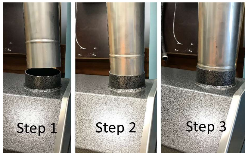
Bild 9. Montering av skorstenen
